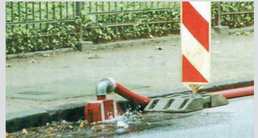
Der SielEx im Einsatz: Hohe Spülleistung bei kontrolliertem Wasseraustritt.
